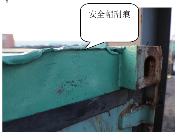
图5 事故现场图四
